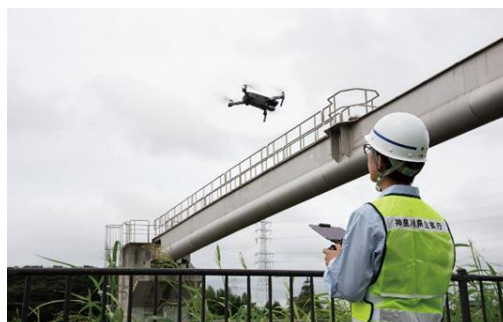
【図6】ドローンによる点検
