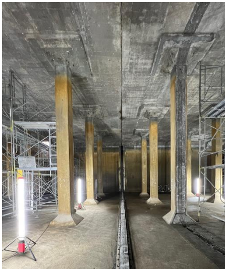
【図 11】耐震補強工事（耐震壁の設置）
