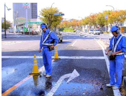
【図10】漏水調査の様子
