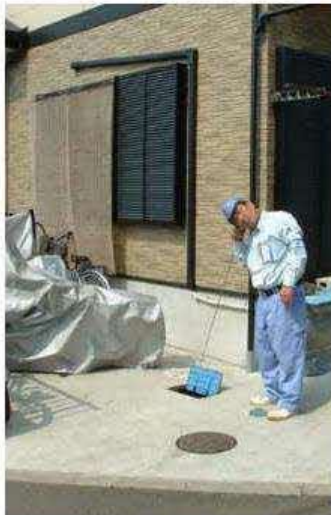
宅地内の漏水調査の様子
