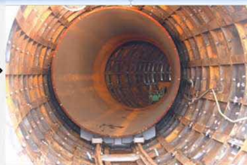
水道管を中に押し込む
