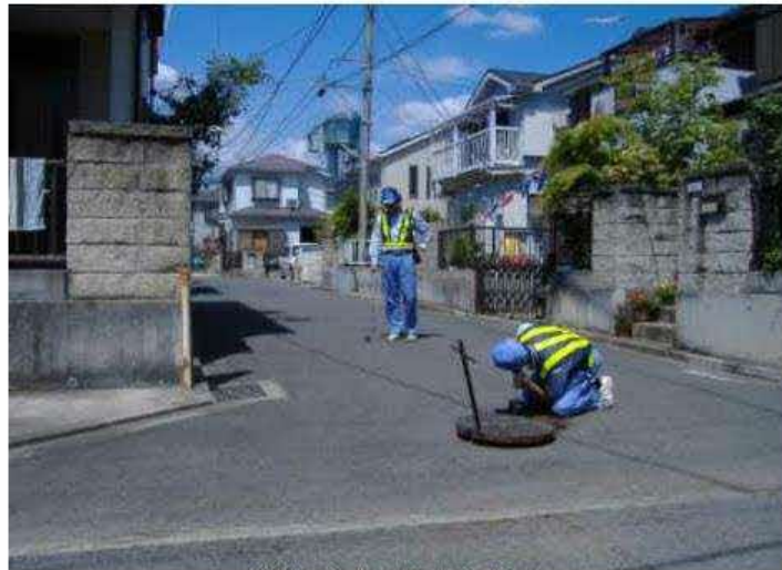
道路での漏水調査の様子
