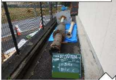
撤去したポンプ(水中ポンプ 55kW)
