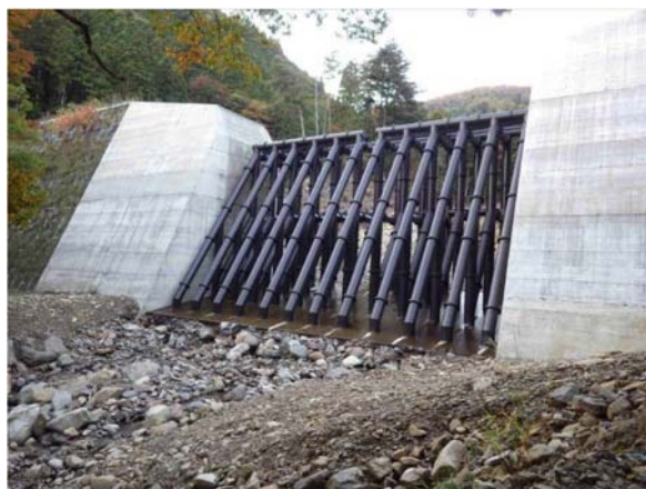
写真 1.4.3 相模川水系 笹子川・滝子川砂防堰堤（透過型砂防堰堤、H26.3 完成）
