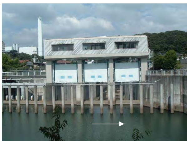
分水路取水庭
