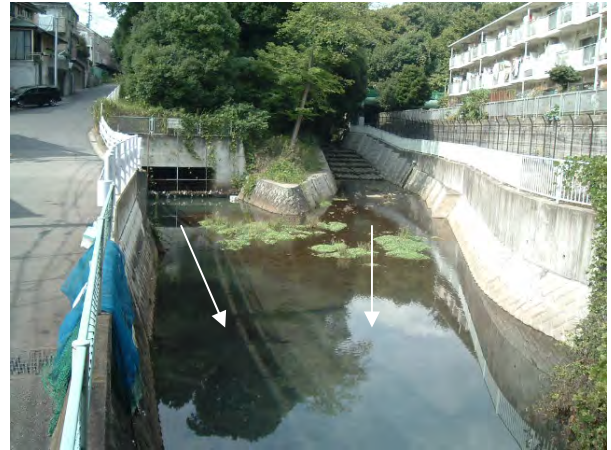
バイパストンネル出口
