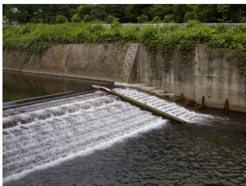
帷子川用賀下橋下流の魚道整備
