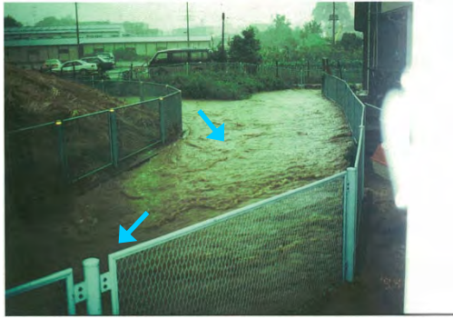
撮影方向①（2号雨水幹線合流点）
