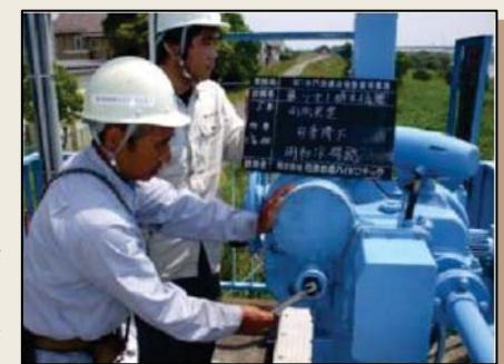
▲河川管理施設の点検状況
