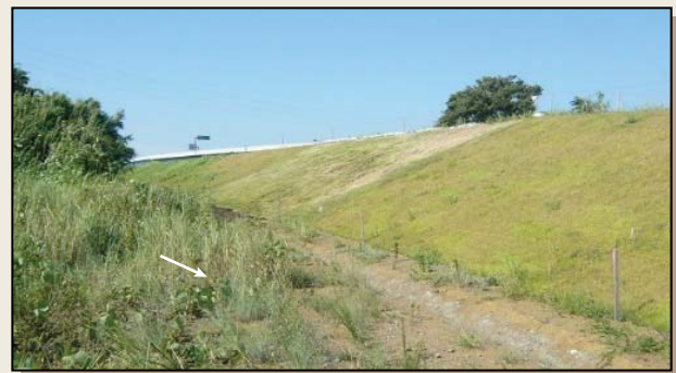
▲整備後の堤防（神奈川県高座郡寒川町一之宮地先）
