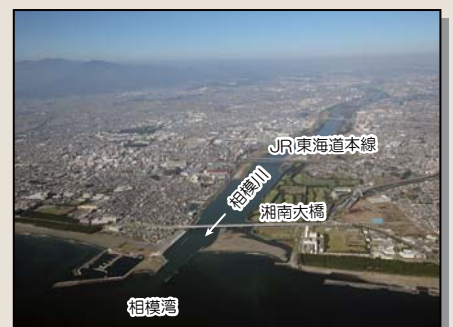
▲下流部(河口付近)
