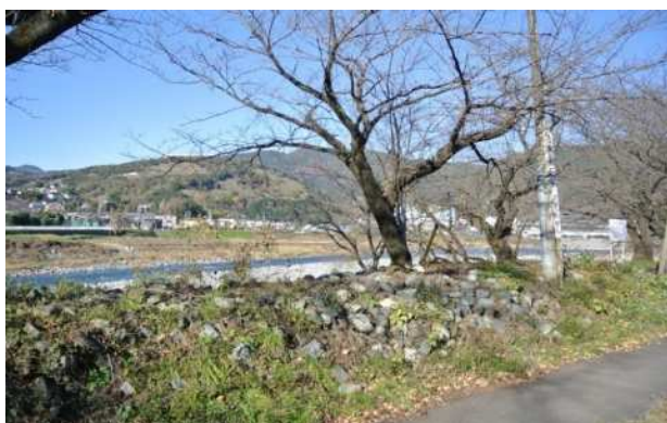
水防用に積上げられた石（大口付近）
