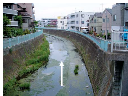
写真 1.8 上野川橋より下流側
