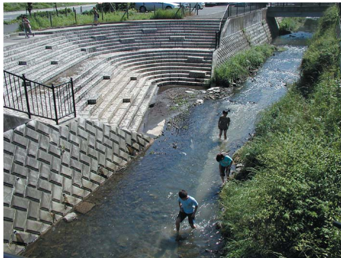
写真 4.14 既設親水護岸（天屋二ノ橋下流）
