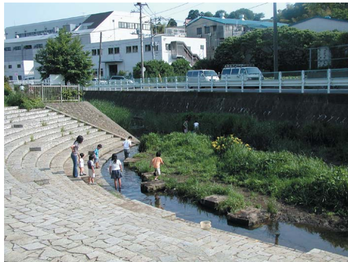
写真 4.15 既設親水護岸（真部橋下流）
