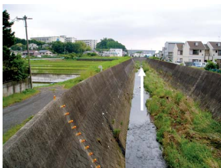
写真 1.11 新大熊橋より下流側
