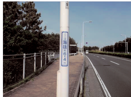
道路照明柱への海拔表示の例
