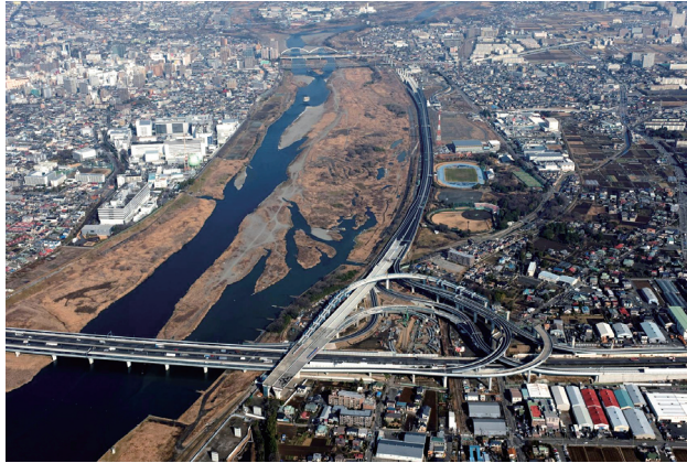
資料) 中日本高速道路株式会社 厚木工事事務所
