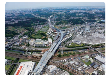
高速横浜環状南線 栄インターチェンジ・ジャンクション
