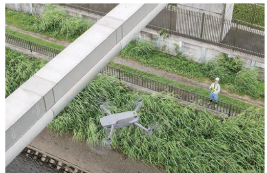
ドローンを活用した水道施設の点検状況
