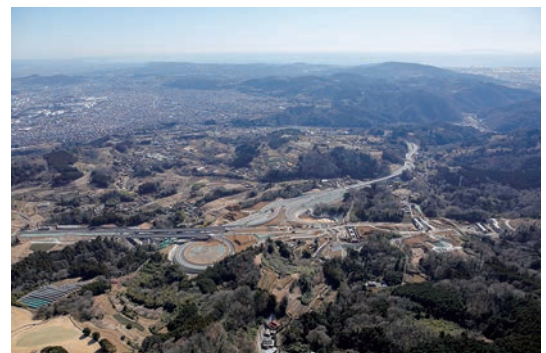
新東名高速道路新秦野インターチェンジ
