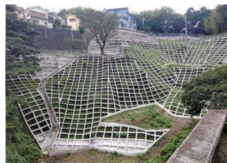
急傾斜地崩壊防止施設 大滝町地区(横須賀市)
