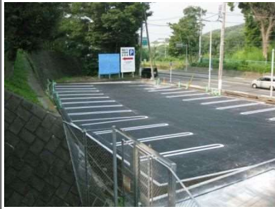
高速バス利用者用駐車場
