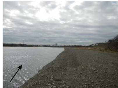
置き砂施工後 (相模川)
