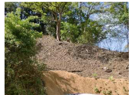
景観等に配慮した防災工事の実施 (鎌倉市笛田)
