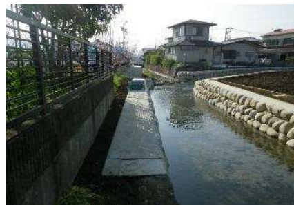
生態系に配慮した災害にも強い水路 (小田原市寺下)
