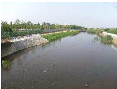
小出川での改修の様子 (寒川町大町)
