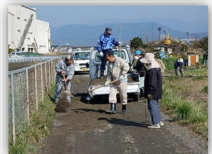
地域ぐるみで実施する農道の補修作業 (小田原市)
