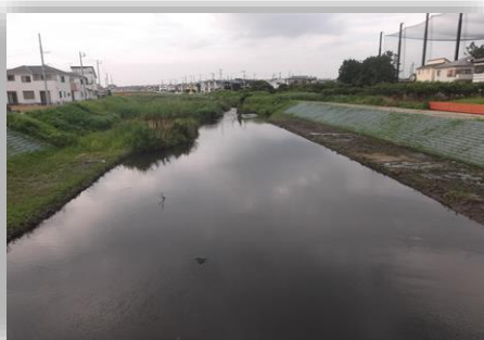
小出川での改修の様子
