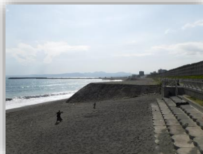
養浜を実施した様子 (茅ヶ崎海岸中海岸地区)
