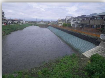
小出川での改修の様子
