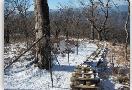
植生保護柵の設置状況
