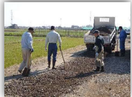
地域ぐるみで実施する農道の補修作業 (伊勢原市)
