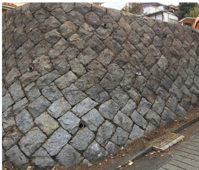
間知石積み擁壁
