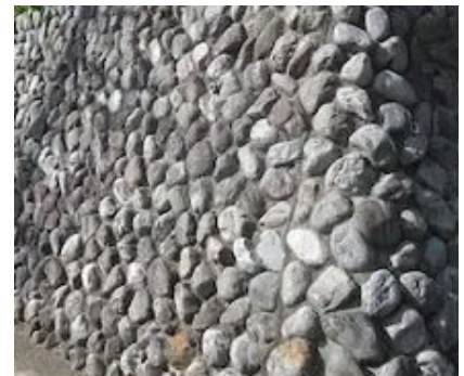
自然石積み擁壁
