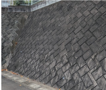
間知ブロック積み擁壁（谷積み）
