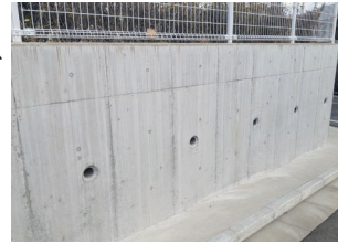
鉄筋コンクリート造擁壁 (L型擁壁)
