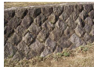
間知石積み擁壁・雑割石積み擁壁
