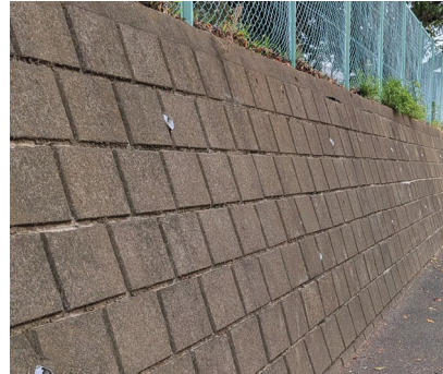
間知ブロック積み擁壁（布積み）
