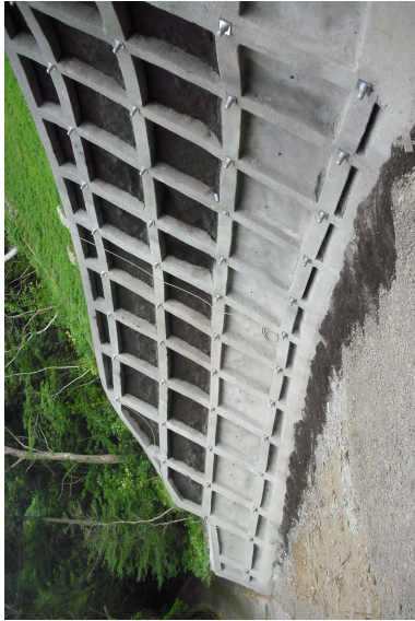
施工時(令和6年7月)
