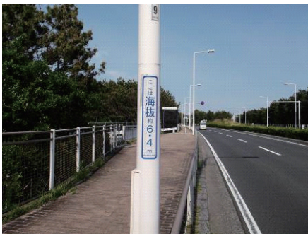
道路照明柱への海抜表示の例 資料：神奈川県道路管理課
