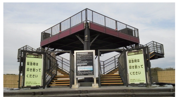
津波避難タワー（県立湘南海岸公園） 資料：神奈川県藤沢土木事務所
