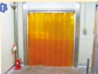
虫が好む波長の光を遮断するカーテンを張り、外部から虫を呼び寄せないようにします。虫の好む波長を出さない蛍光灯を設置する工場もあります。
