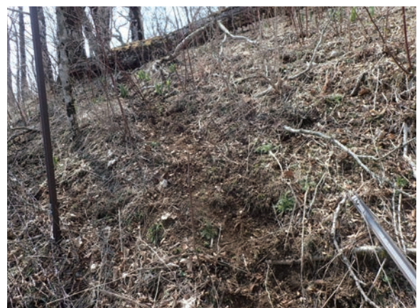
■写真16 破損部から柵内に向けて形成されたシカ道
