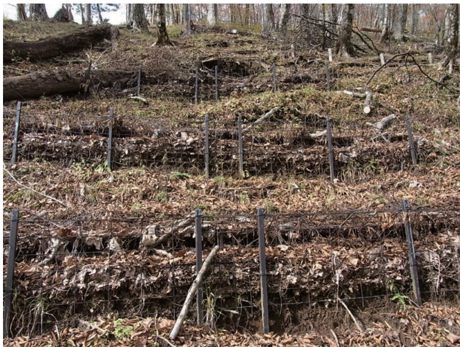
■写真17 金網筋工による土壌保全
