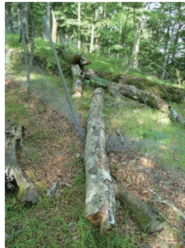
■写真15 倒木による植生保護柵の破損
