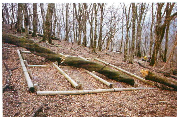
写真13 対策工を直撃した倒木
