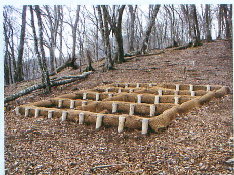
写真9 リター捕捉ロール工
