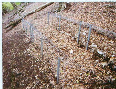
写真10 金網筋工
