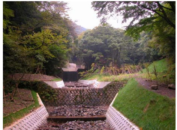
写真Ⅱ-10 治山えん堤
