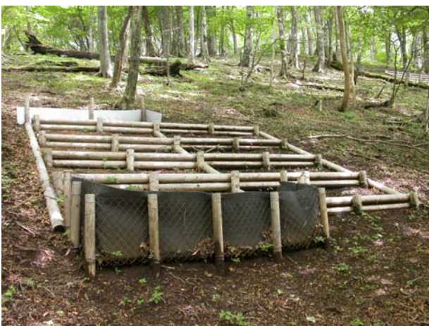
写真V-17 新しい土壌保全工の例
