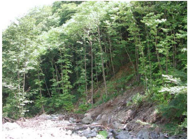
写真 I-3 溪岸侵食による攪乱
