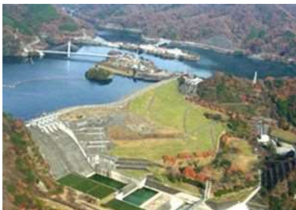
◀ 三保ダムと貯水池
