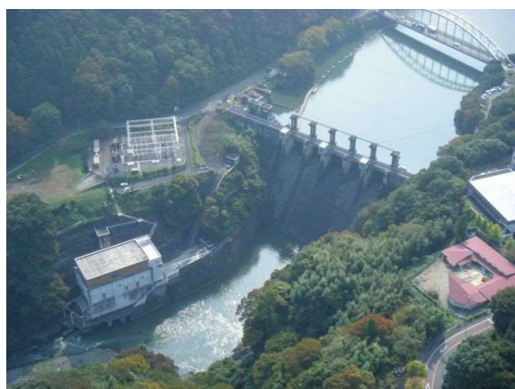
相模ダムと相模発電所
