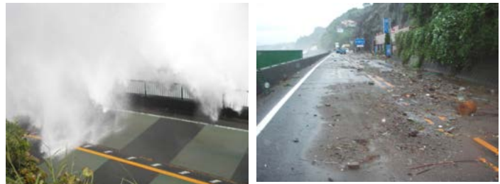
平成19年台風9号による越波被災状況
