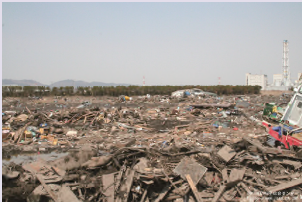
松川浦漁港付近の津波被害の様子 （福島県相馬市尾浜／2011年4月12日）
