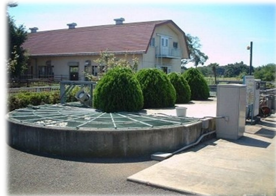
家畜用浄化槽
