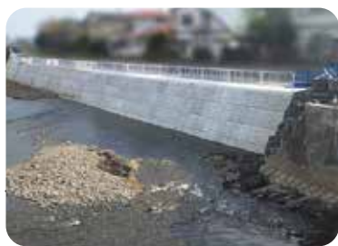
引地川護岸工事
