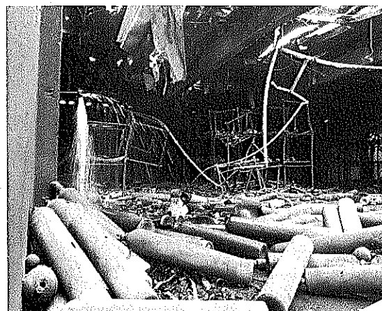
図2 鎮火後の現場
