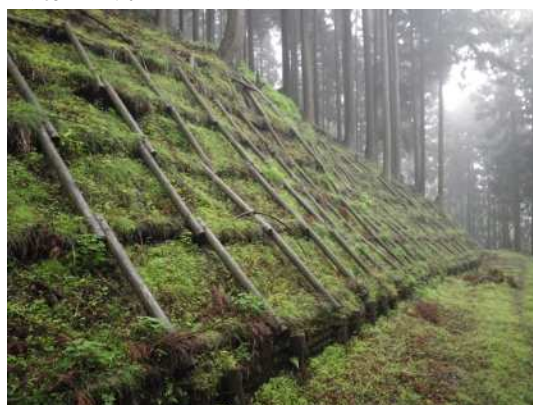
写真33 購入丸太を使用した丸太伏工 (清川村煤ヶ谷地内)
