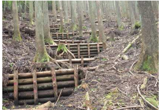
写真27 スコリア土壌の侵食箇所を設置した簡易侵食防止工（南足柄市矢倉沢地内）
