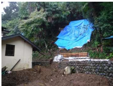
写真6 人家近くの水源林の崩壊地における応急復旧（相模原市緑区寸沢嵐）
