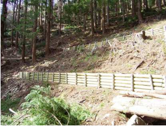
写真24 購入丸太柵工（清川村宮ヶ瀬地内）
