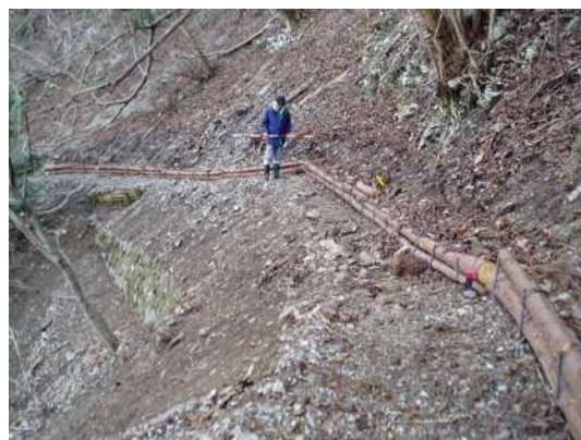
写真32 折り返し毎に路面水を分散させる水切り工 (山北町神尾田地内)
