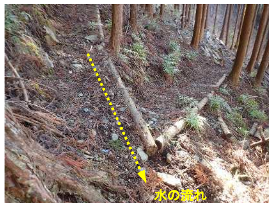
写真32 折り返し毎に路面水を分散させる水切り工 (山北町神尾田地内)
