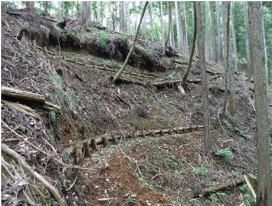
写真25 現採丸太筋工（厚木市七沢地内）
