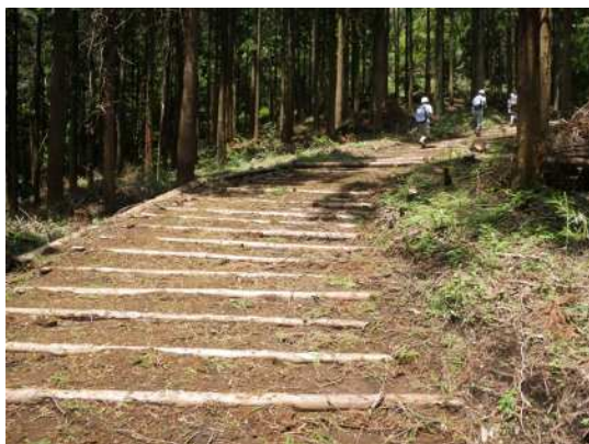
写真34（現採丸太を使用した丸太水切り工） （南足柄市塚原地内）
