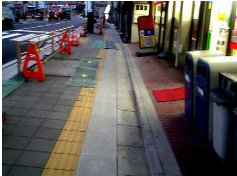
建物と歩道がそれぞれユニバーサルデザイン化されていてもつなぎ目に段差があると、使いづらい。
