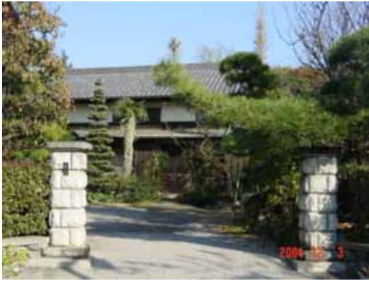
築後 50 年超えの建造物
