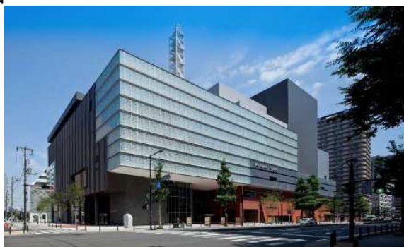
外観図(B1街区)
