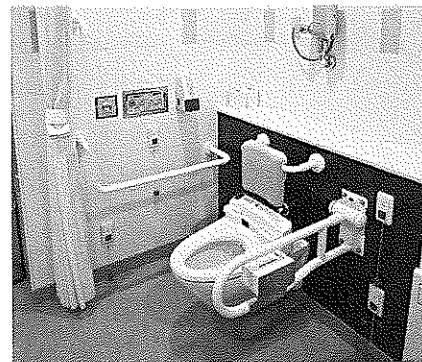
便座を囲むカーテンの設置
