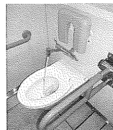
便座後部に置くタイプのオストメイト洗浄装置
