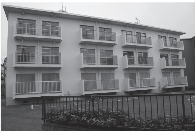
戸手本町の一般公舎外観
