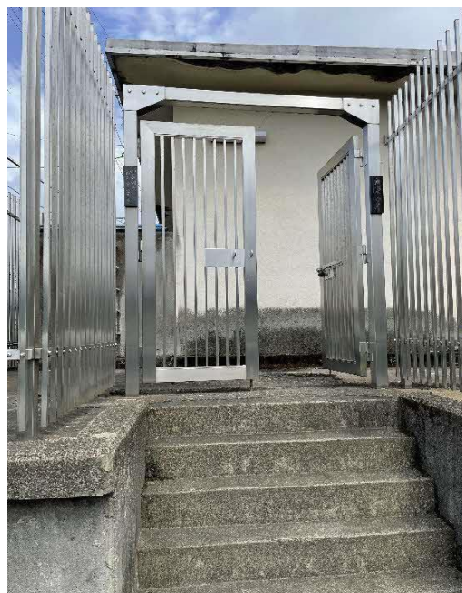
34 飯山揚水ポンプ所用地
