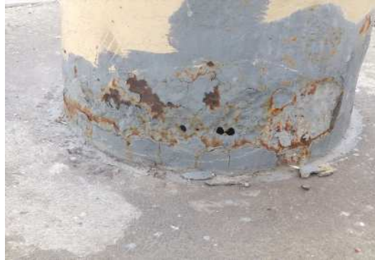
腐食片を取り除いた状態の例（下部）
