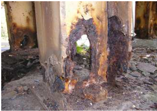
腐食片を取り除いた状態の例（下部）
