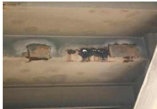
腐食片を取り除いた状態の例（階段部）
