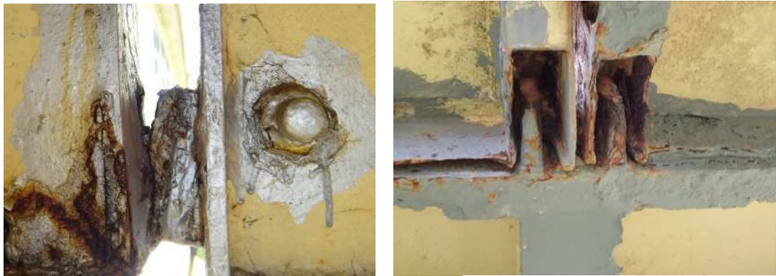
フックの溶接の状態（接合部）
