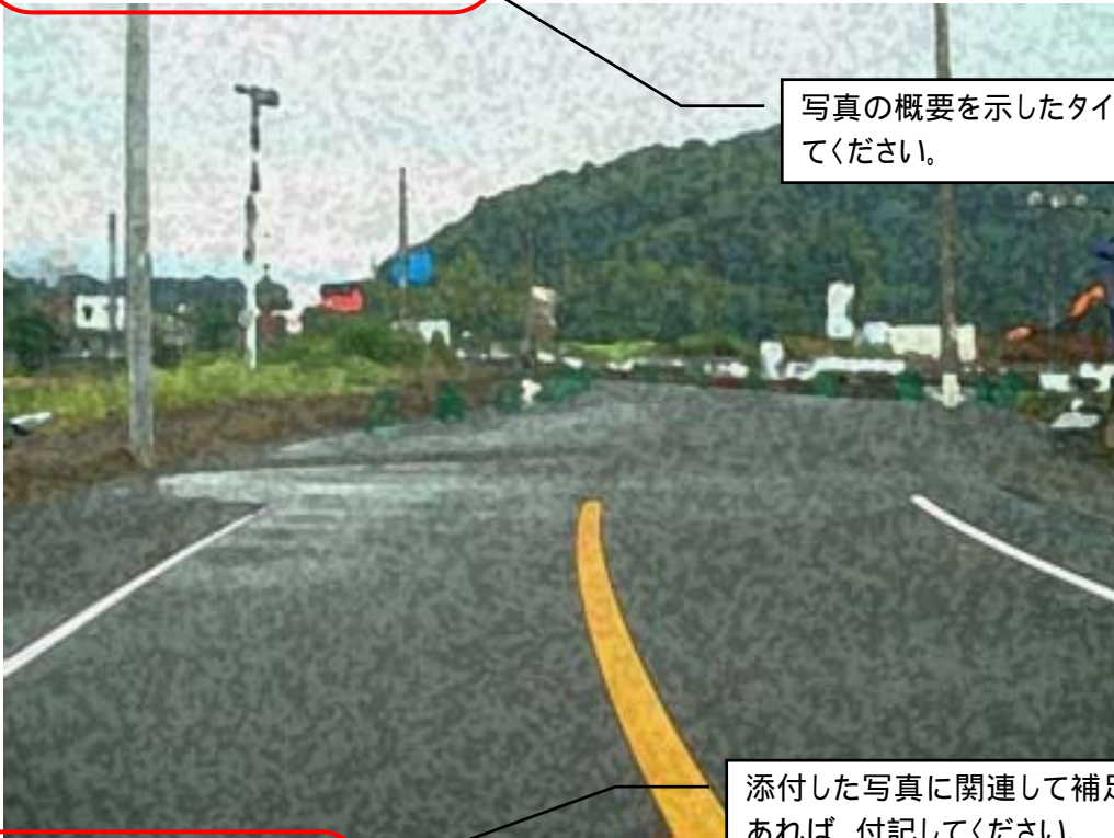
写真1 (現場全景・工事施行前)
