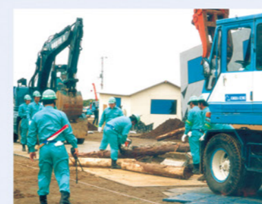
道路啓開・復旧訓練
