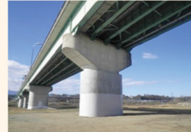
① 橋脚の補強
