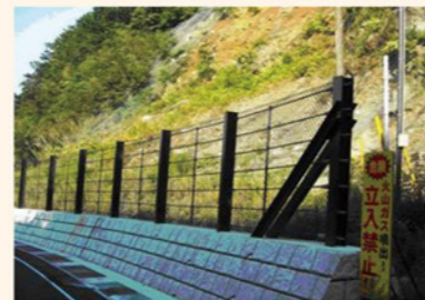
② 落石・土砂崩落対策
