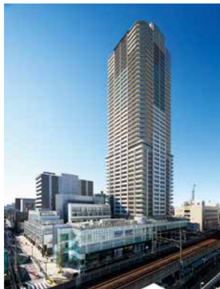
建設中の新東名高速道路、リニア中央新幹線、小杉町3丁目中央地区市街地再開発事業
