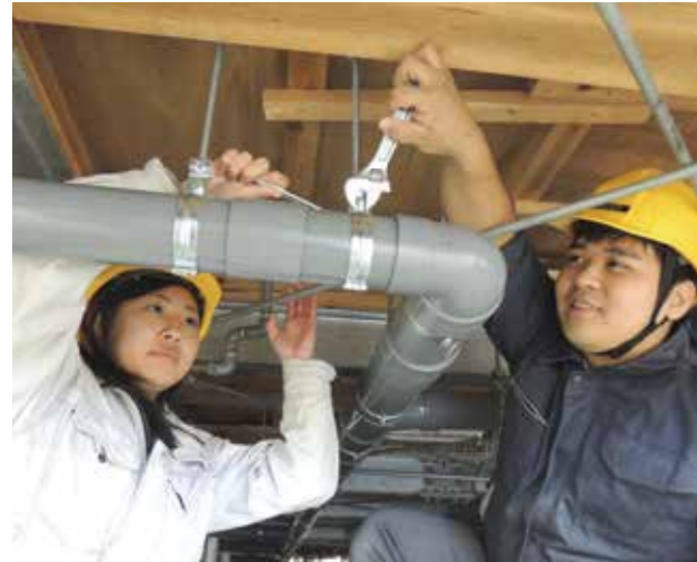
建物施工の職業訓練の様子
