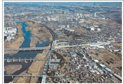
建設中のさがみ縦貫道路
