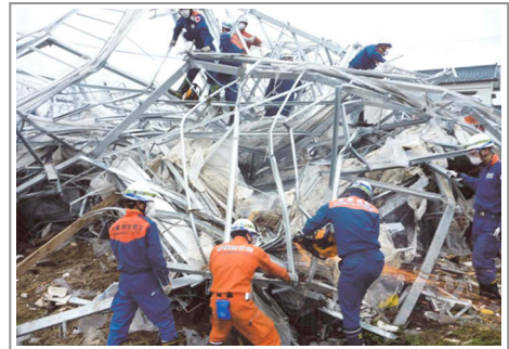
被災地での復旧活動
