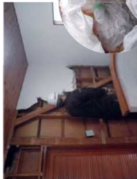
石綿含有建材(写真はヒール床スイル)は、他の建材と異なるように処理しながら手作業により取り外し、梱包しなければなりません。
