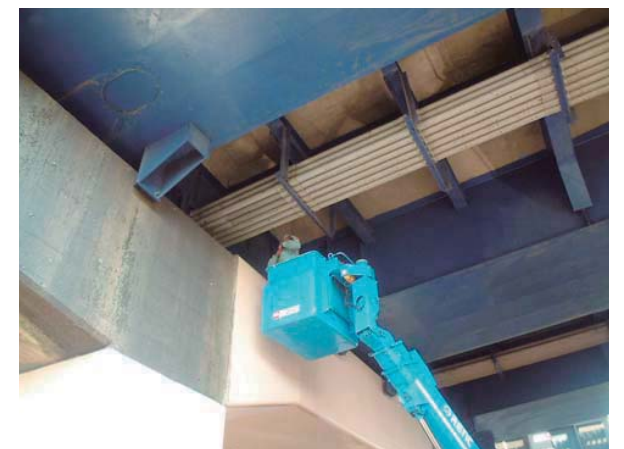
■ 橋りょうの点検
