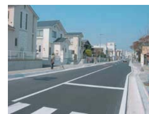
電線類の地中化
