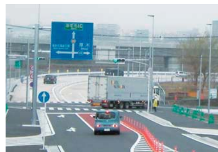
都市計画道路河原口中新田線(海老名市)
