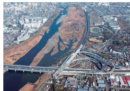
さがみ縦貫道路(海老名市)
