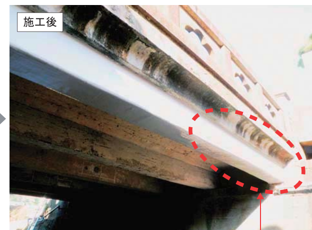
損傷箇所を補修
