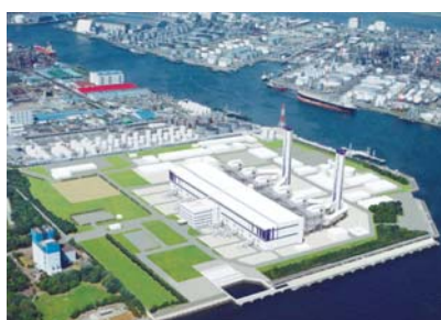
■川崎火力発電所(東京電力株)
