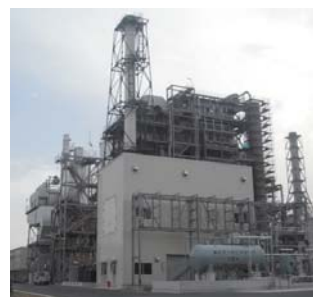
■バイオマス発電 (川崎バイオマス発電株)
