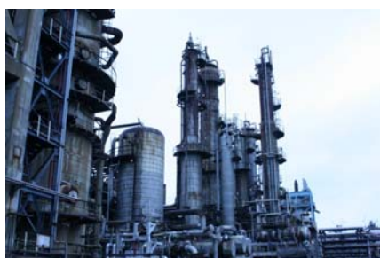
■排気ガスエネルギーを動力源とした発電 (東燃ゼネラル石油(株)・東燃化学(株))
