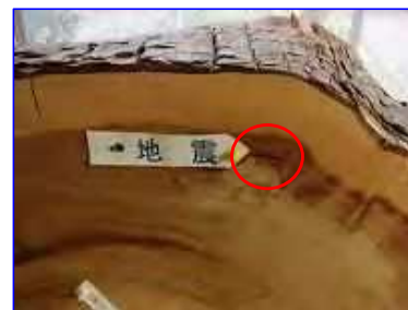
大地震での落石によるとみられる痕跡
