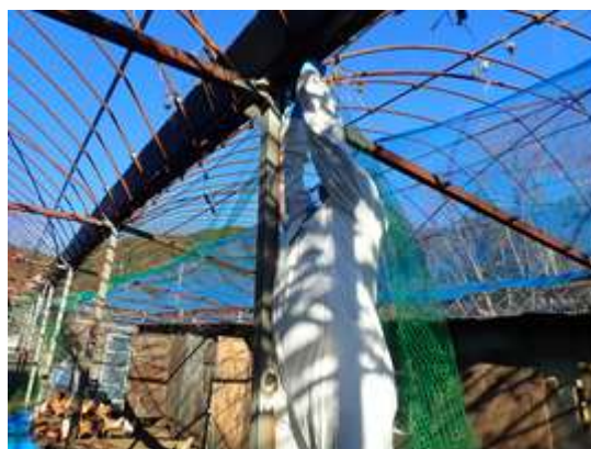
写真7 防鳥ネット設置作業
