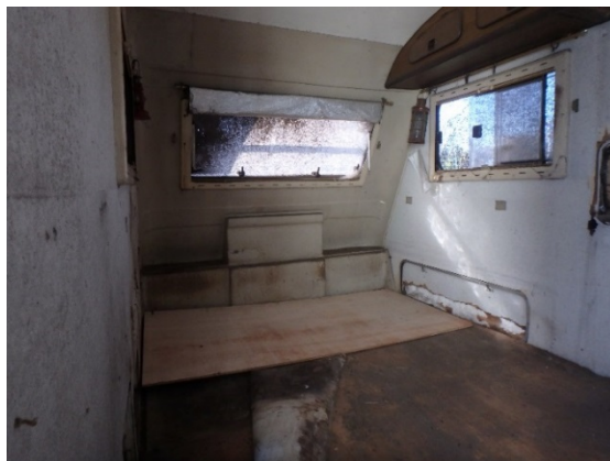
写真6 キャビン内部の様子
